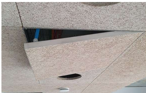
Image : Exemple d'installation dans un plafond en laine de bois
