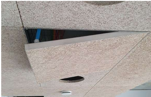
Bild: Einbaubeispiel in einer HWL-Decke
